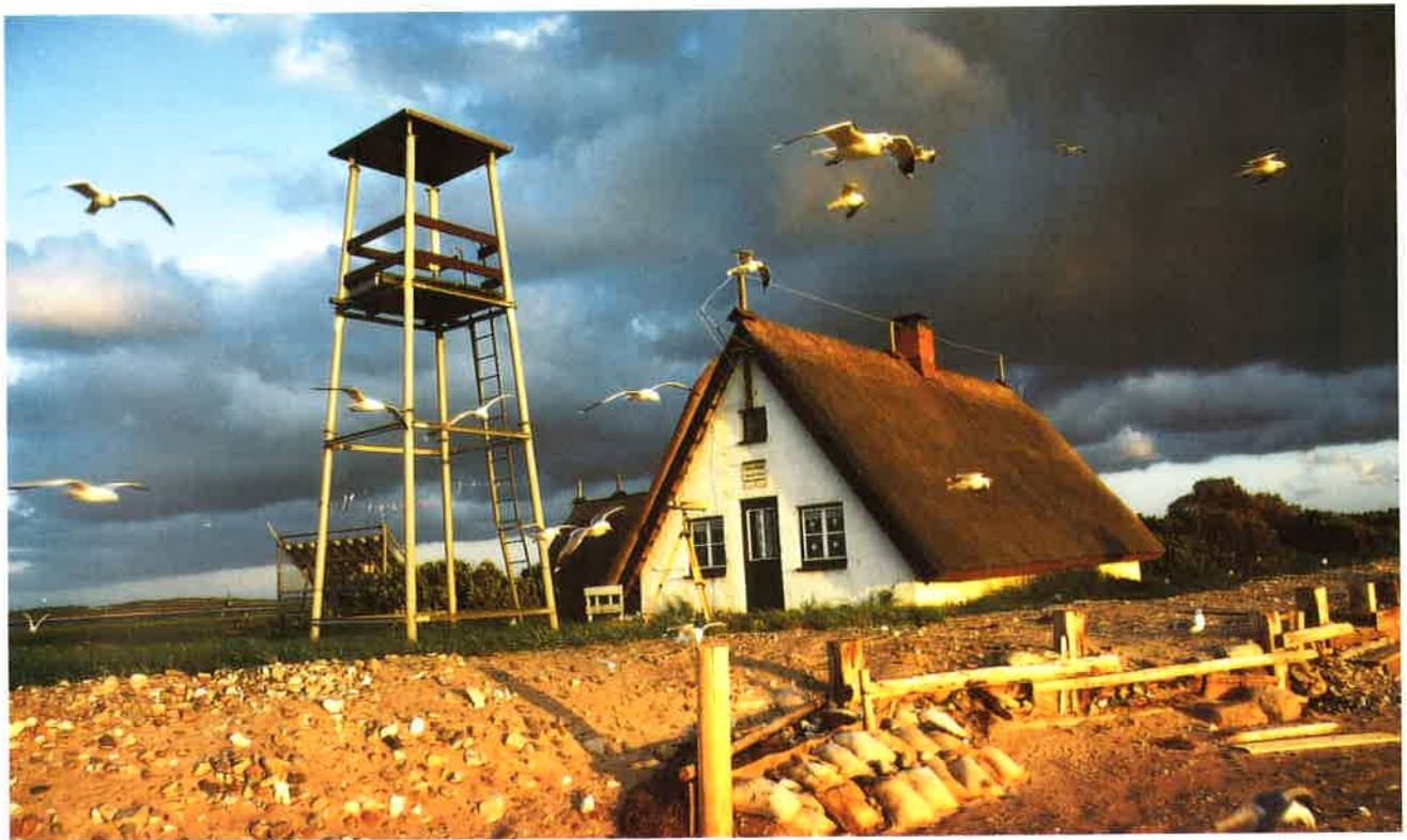
Abb. 1: Das Stationsgebäude mit Beobachtungsturm und Solaranlage.
